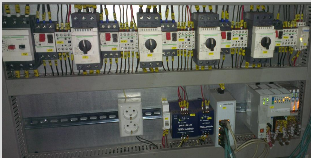
Табла за управление на кран с релейно-контакторна логика и с честотни регулатори, свързани в мрежа с логически контролер
