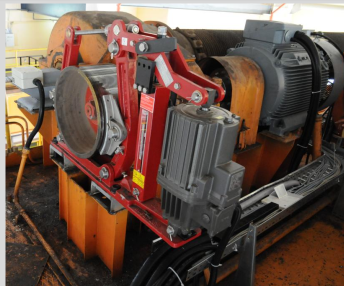
Подемен механизъм на 200-тонен кран
