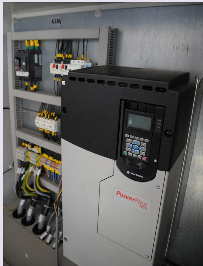
Табло с контролер и операторски дисплей за управление на кран
