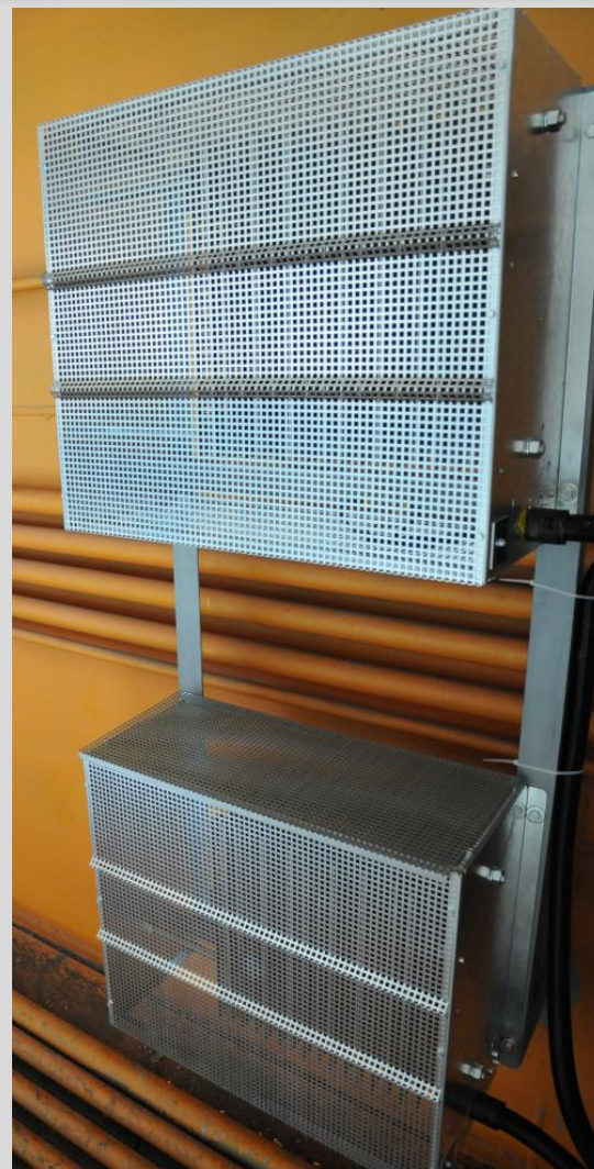
Спирачни резистори на честотен регулатор
