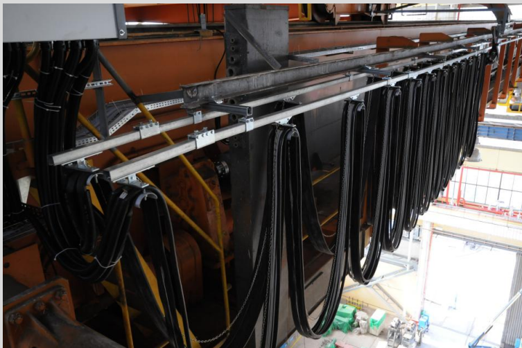
Фестонно захранване на мостов кран
