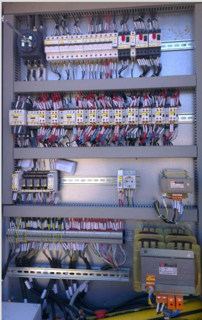
Табла за управление на кран с релейно-контакторна логика и с честотни регулатори, свързани в мрежа с логически контролер
